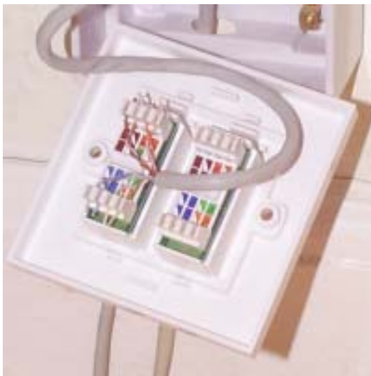
Σχήμα 7-2 Το εσωτερικό μιας διπλής επίτοιχης πρίζας με τοποθετημένο ένα καλώδιο
